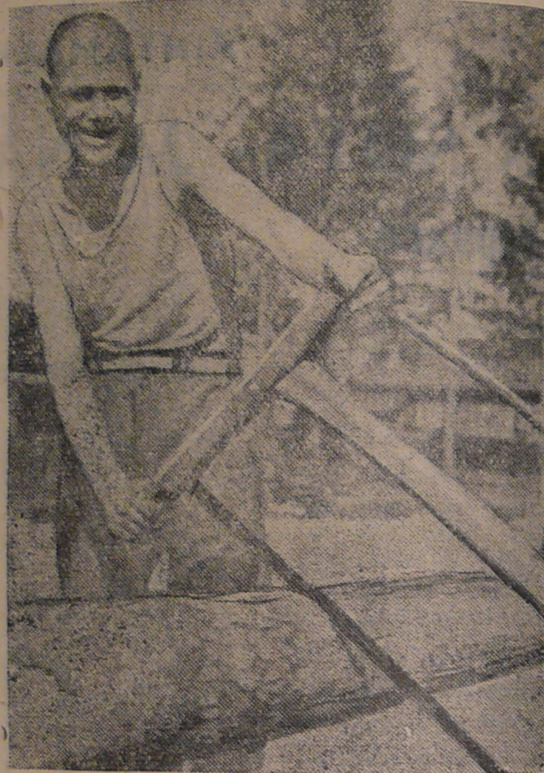
JR 31:n korpraali Antti Piirainen saunan rakentamishommissa.
